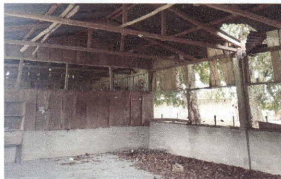
Foto 8: Reparación de muro de contención y repello.
