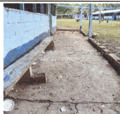
Foto 4: Reparación de piso de torta de concreto
