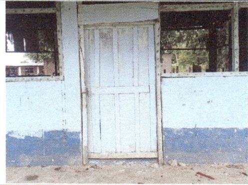
Foto 2: Sustitución de puerta.
