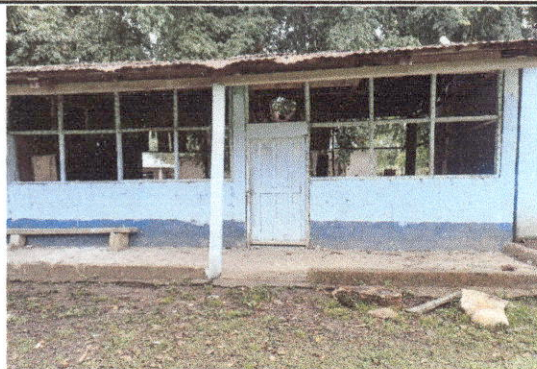
Foto 3: Sustitución de balcones de metal
