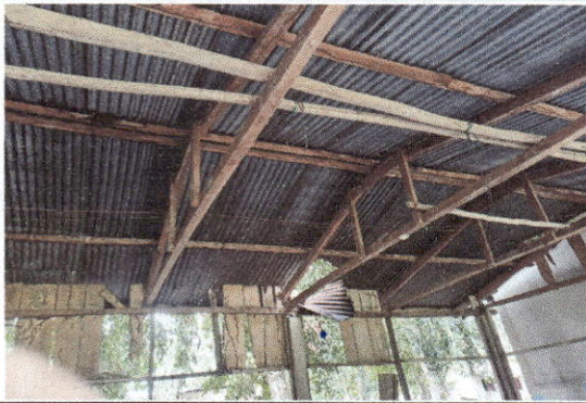
Foto 1: Sustitución de lámina, por lámina troquelada aluzinc calibre 26 y Sustitución de estructura de soporte de madera, por metal
