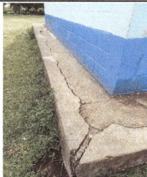
Foto 5: Reparación de banquetas de concreto
