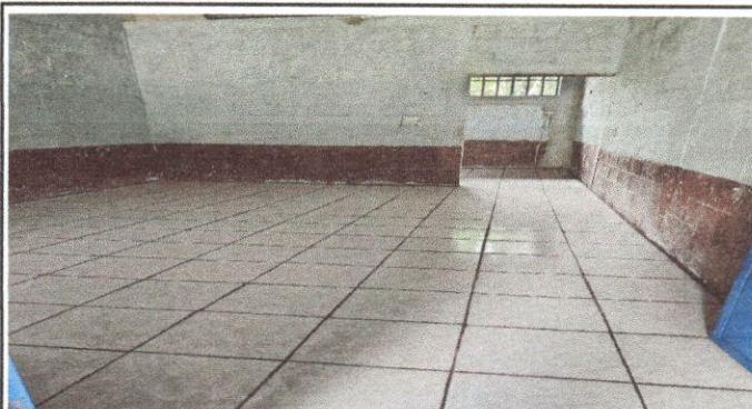
Foto 4: Mejoramiento de piso liquido concreto a piso ceramico
