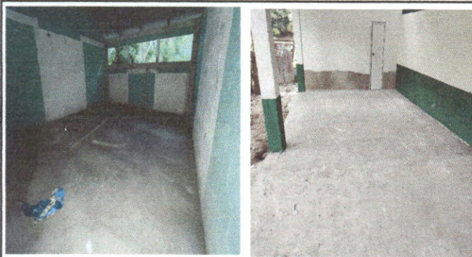
Foto 3: Sustitución de piso de torta de concreto
