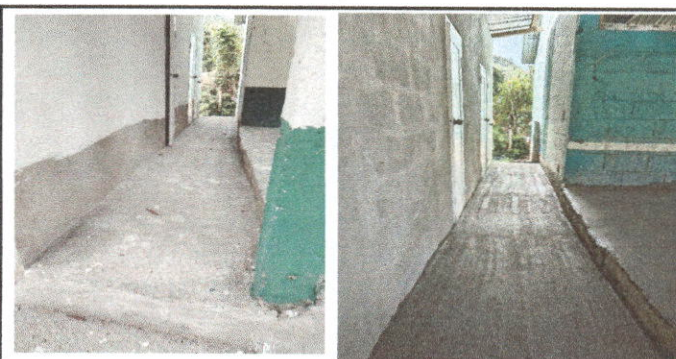
Foto 6: Sustitución de torta de torta de concreto en pasillo entre los baños y las aulas
