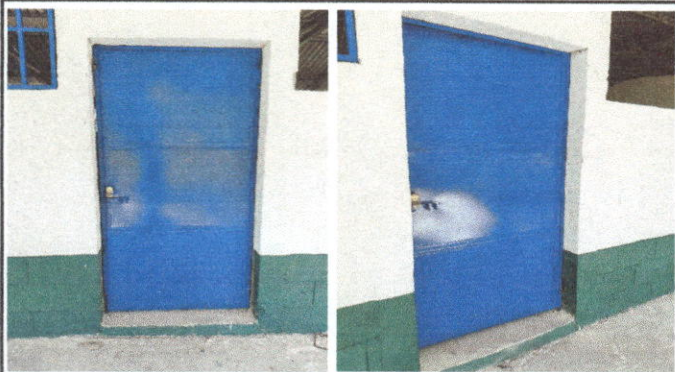
Foto 1: Sustitución de puerta
