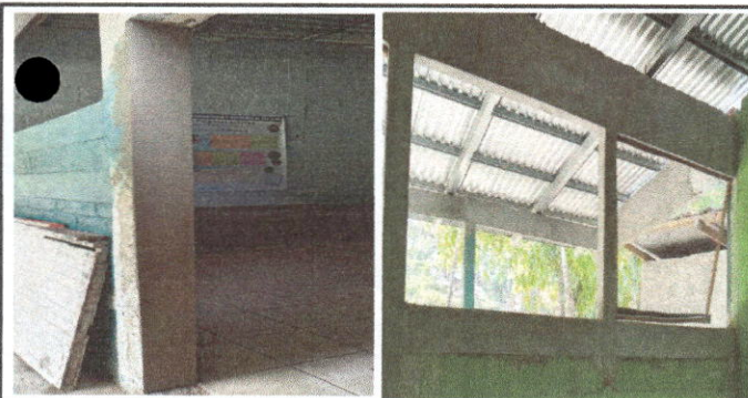
Foto 5: Repello tallado en ventanas y puertas
