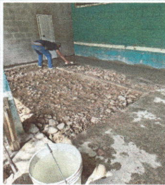
Foto 3: Sustitución de piso de torta de concreto
