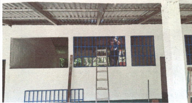
Foto 2: Sustitución de balcones
