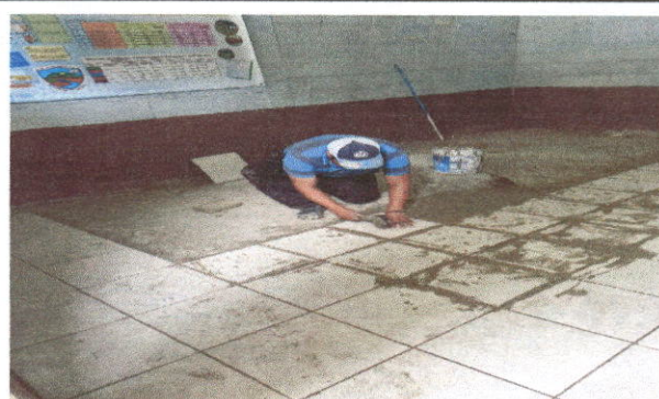
Foto 4: Mejoramiento de piso liquido concreto a piso ceramico
