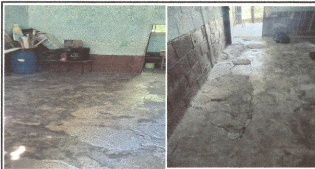
Foto 2 Sustitución de piso de cemento liquido
