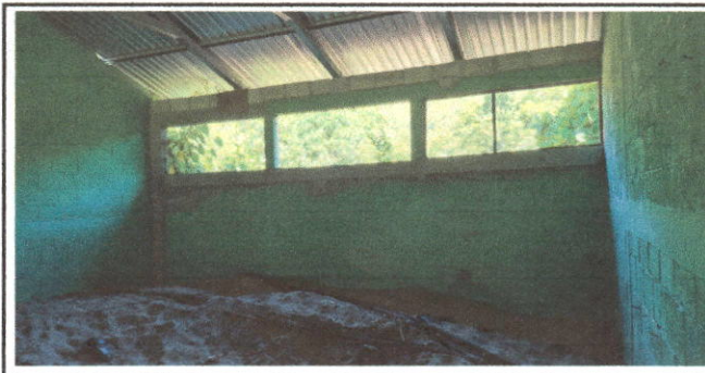
Foto 4 Sustitucion de balcones
