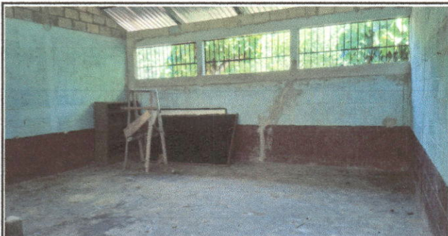
Foto 1 Sustitución de piso de cemento liquido
