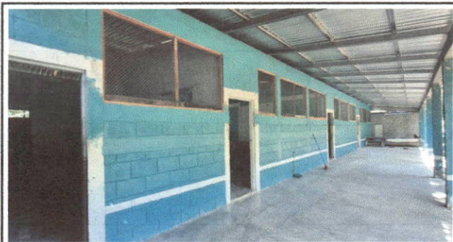
Foto 3 Sustitución de balcones
