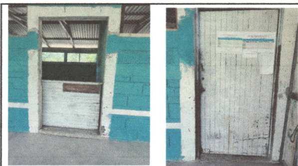
foto 5 Sustitución de puerta
