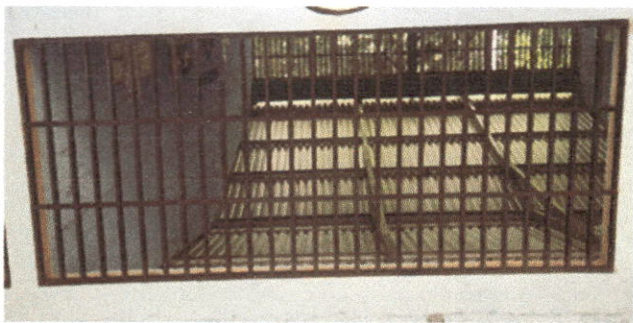
Foto 1: fabricacion e instalacion de ventanas - balcon de metal
