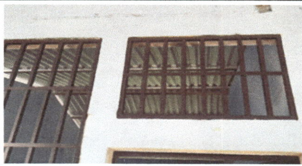
Foto 3: fabricacion e instalacion de ventanas - balcon de metal
