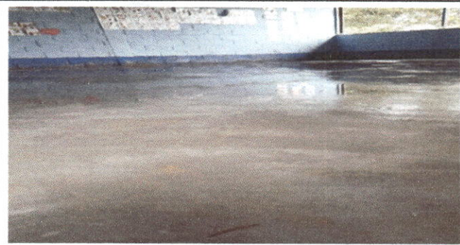
Foto 5: sustitucion de piso liquido
