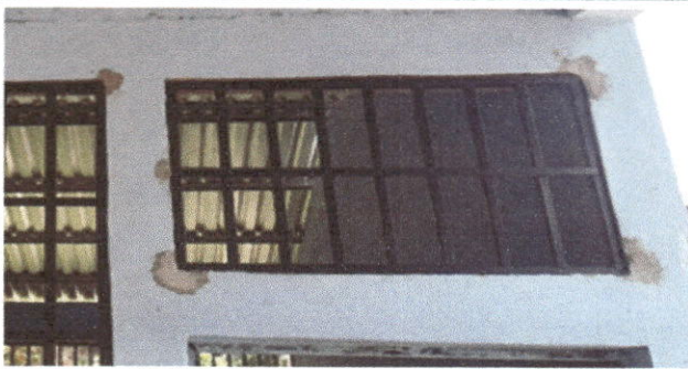
Foto 2: fabricacion e instalacion de ventanas - balcon de madera
