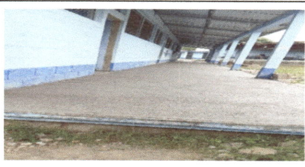
Foto 6: sustitucion de piso de torta de concreto
