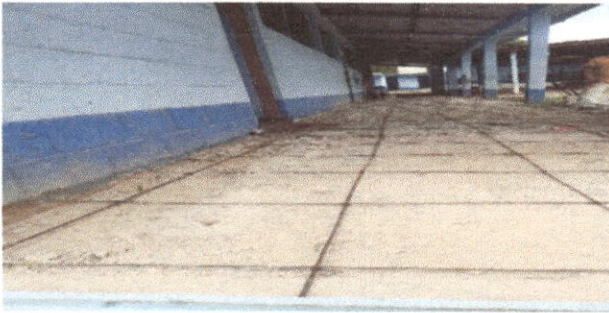
Foto 6: sustitución de piso de torta de concreto
