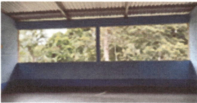
Foto 1: fabricación e instalación de ventanas - balcón de metal
