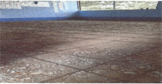
Foto 5: sustitución de piso liquido
