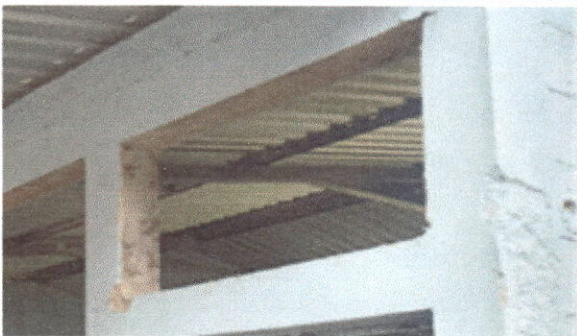
Foto 2: fabricación e instalación de ventanas - balcón de madera
