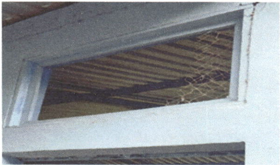
Foto 3: fabricación e instalación de ventanas - balcón de metal
