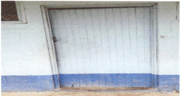
Foto 4: Fabricacion e instalacion puerta de metal en modulo
