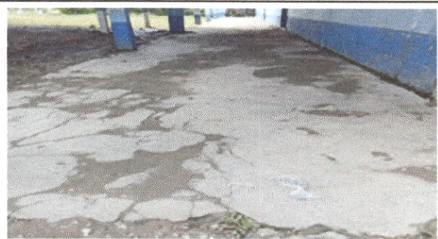
Foto 6: Sustitucion de piso de torta de concreto
