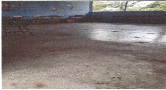
Foto 5: Sustitucion de piso de cemento liquido
