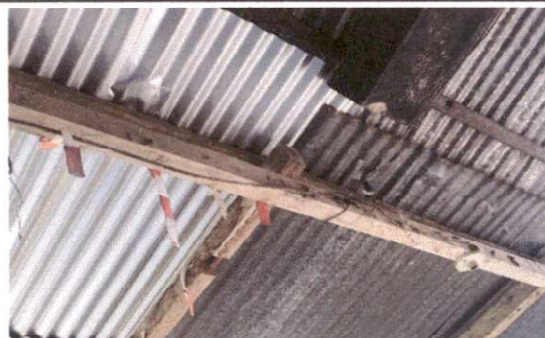
FOTO 4: SUSTITUCION DE CABLEADO ELECTRICO
