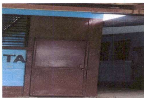
Foto 3: SUSTITUCION DE PUERTAS
