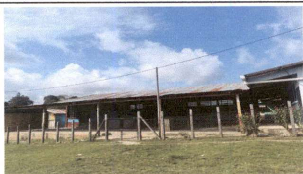
Foto1: SUSTITUCION DE LAMINA POR LAMINA TROQUELADA ALUZINC
