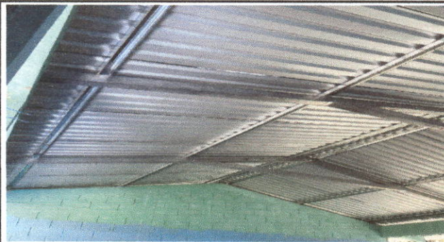
Foto 3: SUSTITUCION DE ESTRUCTURA DE SOPORTE
