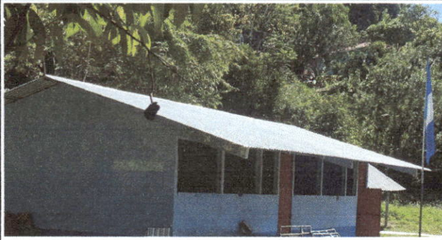
Foto 1: SUSTITUCION DE TECHO
