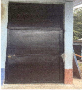
Foto 1: SUSTITUCION DE PUERTAS
