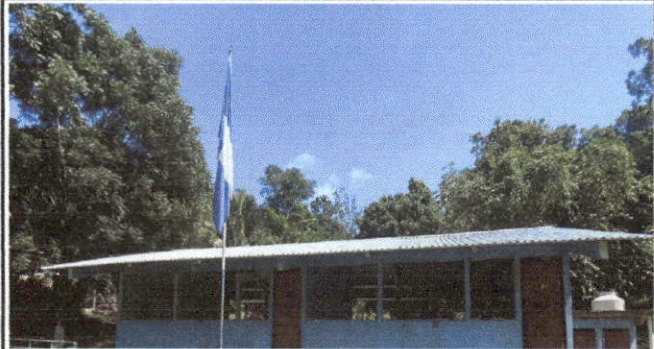
Foto 2: SUSTITUCION DE TECHO
