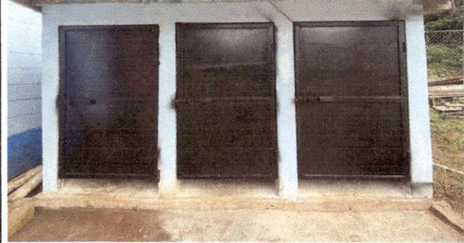
Foto 2: SUSTITUCION DE PUERTAS EN SERVICIO SANITARIO
