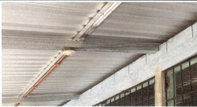
Foto 3: SUSTITUCION DE SISTEMA ELECTRICO
