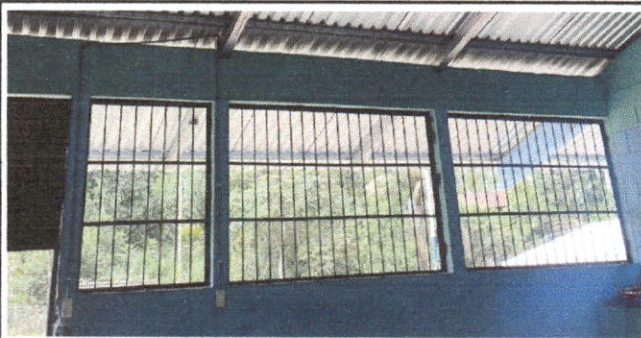
Foto 5: SUSTITUCION DE BALCONES
