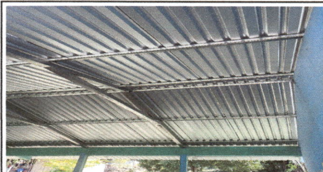
Foto 4: SUSTITUCION DE ESTRUCTURA DE SOPORTE
