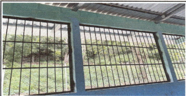
Foto 6: SUSTITUCION DE BALCONES
