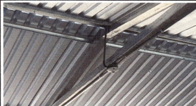
Foto 4: SUSTITUCION DE SISTEMA ELECTRICO
