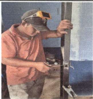
Foto 1: SUSTITUCION DE PUERTAS
