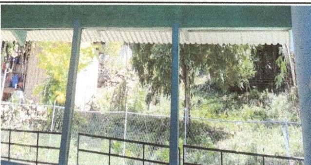
Foto 6 SUSTITUCION DE BALCONES
