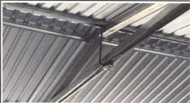
Foto 3: SUSTITUCION DE SISTEMA ELECTRICO
