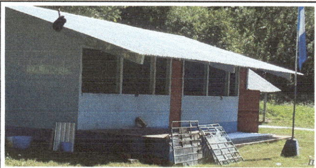
Foto 5: SUSTITUCION DE BALCONES
