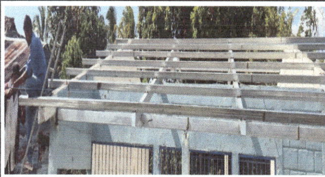
Foto 3: SUSTITUCION DE ESTRUCTURA DE SOPORTE
