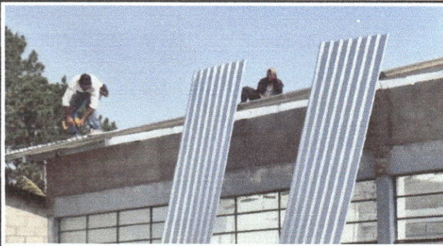
Foto 1: SUSTITUCION DE TECHO
