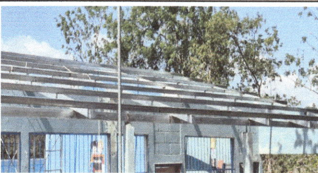
Foto 4: SUSTITUCION DE ESTRUCTURA DE SOPORTE
