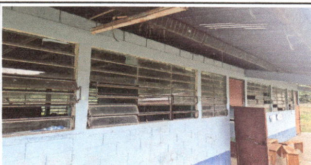
Foto 6: SUSTITUCION DE BALCONES
