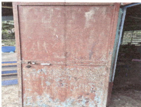
Foto 1: SUSTITUCION DE PUERTAS
