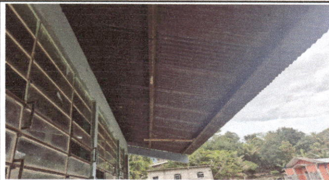
Foto 4: SUSTITUCION DE ESTRUCTURA DE SOPORTE
