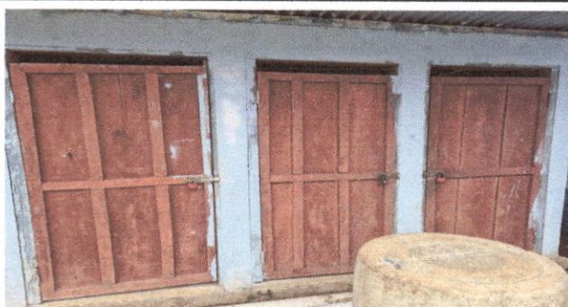
Foto 2: SUSTITUCION DE PUERTAS EN SERVICIO SANITARIO
