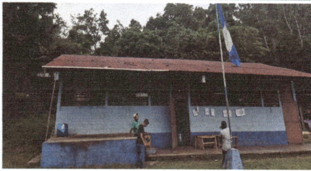
Foto 1: SUSTITUCION DE TECHO
