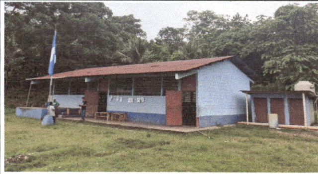
Foto 2: SUSTITUCION DE TECHO
