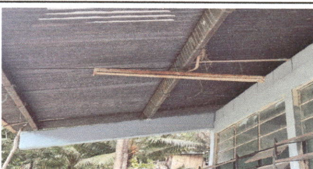
Foto 4: SUSTITUCION DE SISTEMA ELECTRICO
