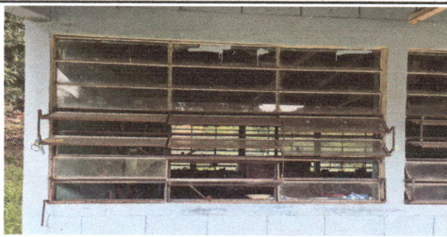
Foto 5: SUSTITUCION DE BALCONES
