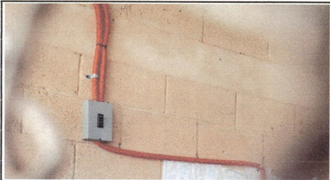
Foto 7: Sustitución de tablero de flipones, Sustitución de flipones y Reparación de cableado eléctrico.
