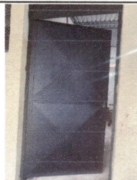
Foto 2: Mantenimiento a estructura de puerta de metal y sustitucion de chapa.
