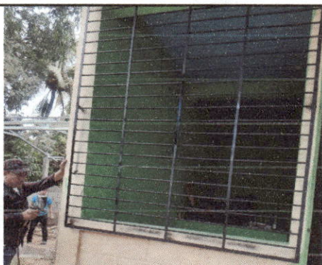
Foto 3: Mantenimiento a balcones de metal
