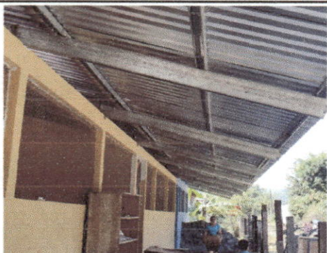
Foto 1: Sustrucción de estructura de soporte de madera, por metal
