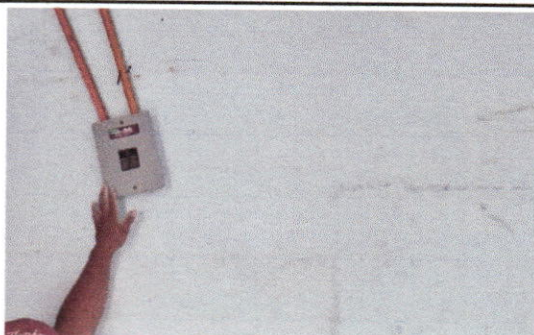
Foto 7: Sustitución de cuadro de flippers, sustitución de flippers y reparación de cableado eléctrico
