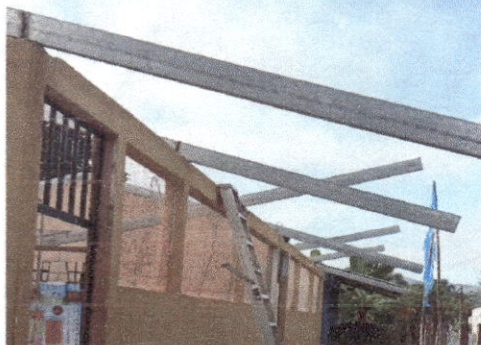
Foto 1: Sustrucción de estructura de soporte de madera, por metal
