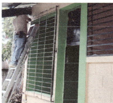
Foto 3: Mantenimiento a balcones de metal
