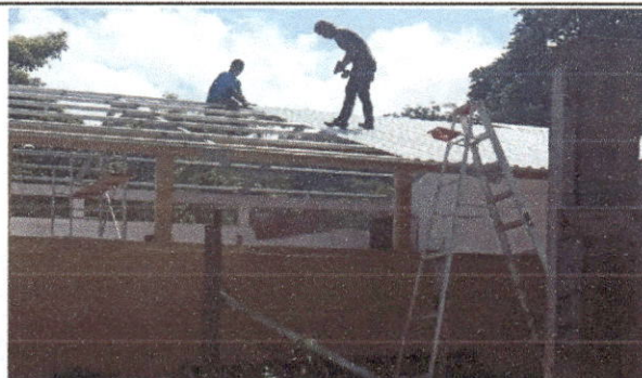
Foto 5: Sustrucción de lámina, por lámina troquelada aluzinc calibre 26
