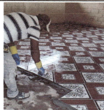
Foto 4: Sustrucción de piso de cemento liquido por piso cerámico
