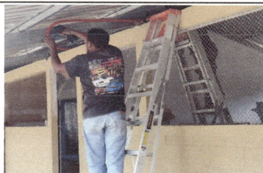
Foto 6: Sustrucción de focos ahorradores, Sustrucción de plafoneras y Reparacion de sistema electrico.
