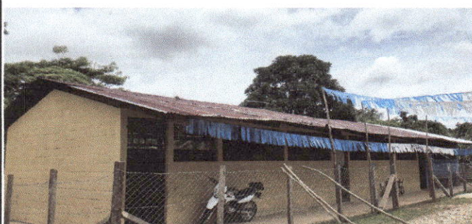
Foto 5: Sustrucción de lámina, por lámina troquelada aluzinc calibre 26
