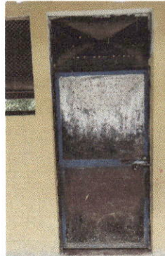
Foto 2: Mantenimiento a estructura de puerta de metal y sustitución de chapa.
