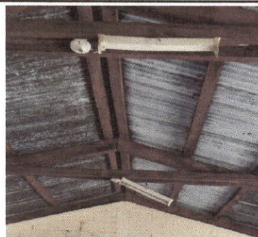
Foto 6: Sustrucción de focos ahorradores, Sustrucción de plafoneras y Reparación de sistema eléctrico.
