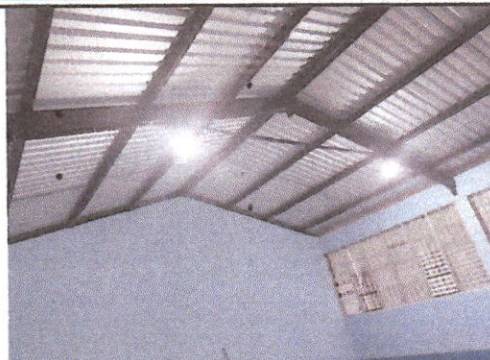
Foto 2: SUSTITUCIÓN DE DUCTO ELECTRICO MAS ACCESORIOS
