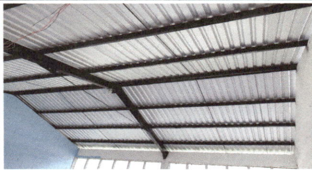
Foto 3: MANTENIMIENTO DE ESTRUCTURA DE SOPORTE
