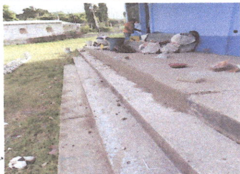
Foto 1: REPARACIÓN DE BANQUETAS DE CONCRETO
