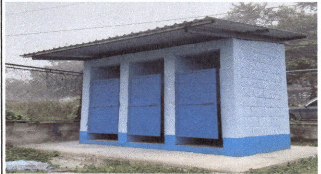
Foto 4: MANTENIMIENTO A PUERTAS
