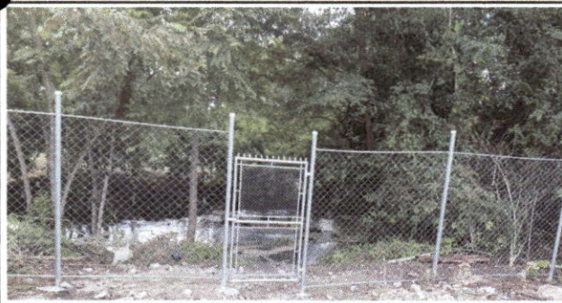
Foto 5: REPARACIÓN DE TUBO HG Y MALLA GALVANIZADA
