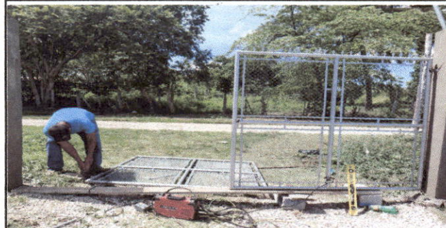
Foto 6: SUSTITUCIÓN DE PORTON
