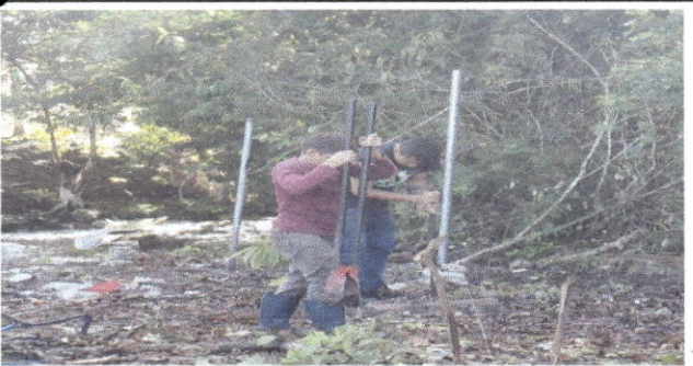
Foto 5: REPARACIÓN DE TUBO HG Y MALLA GALVANIZADA
