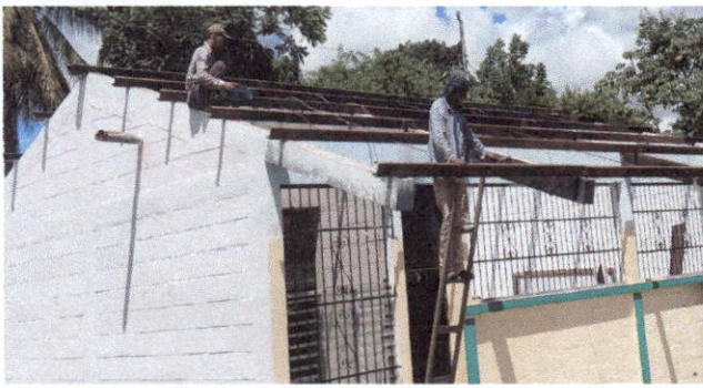
Foto 3: MANTENIMIENTO DE ESTRUCTURA DE SOPORTE
