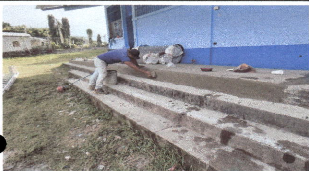
Foto 1: REPARACIÓN DE BANQUETAS DE CONCRETO
