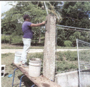
Foto 3: REPELLO EN MURO
