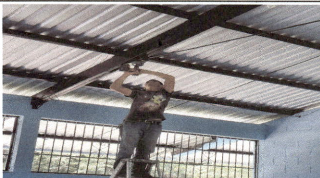
Foto 2: SUSTITUCIÓN DE DUCTO ELECTRICO MAS ACCESORIOS
