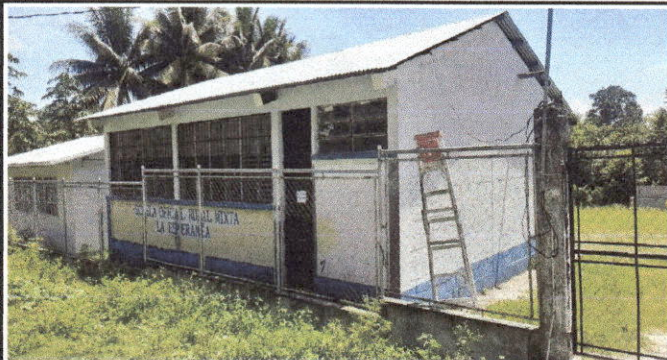
Foto 1: PINTURA EN MUROS INTERIORES E EXTERIORES
