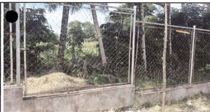
Foto 5: REPARACIÓN DE TUBO HG Y MALLA GALVANIZADA
