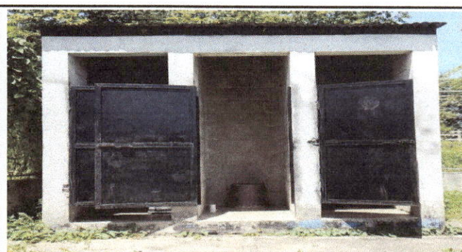
Foto 4: MANTENIMIENTO A PUERTAS
