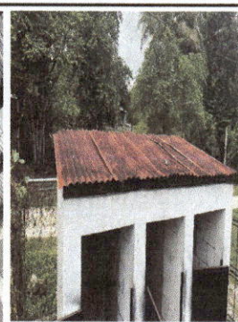
Foto 2: SUSTITUCIÓN DE LAMINA, POR LAMINA TROQUELADA ALUZINC CALIBRE 26
