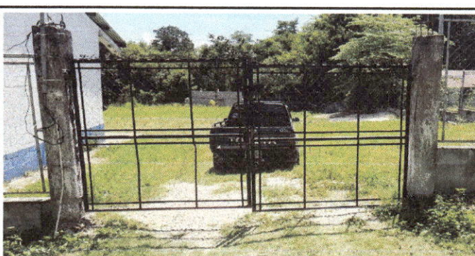
Foto 6: SUSTITUCIÓN DE PORTON
