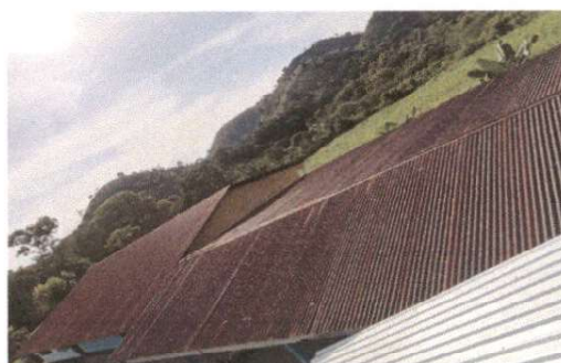
Foto 4: Sustitución de lámina
