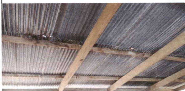
Foto 2: Sustitución de estructura de madera por metal
