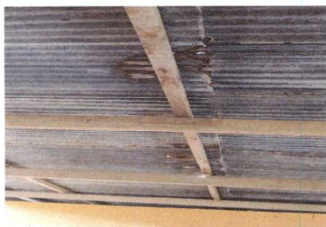
Foto 3: Sustitución de lámina
