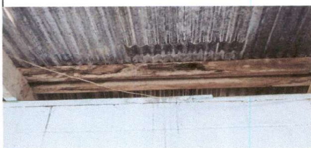
Foto1: Sustitución de estructura de madera por metal
