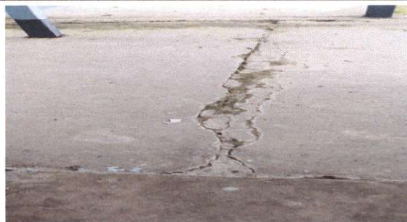
Foto 6: Sustitución de piso de concreto
