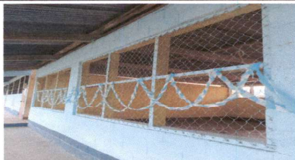
Foto 5: Pintura en muros interiores y exteriores
