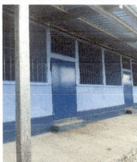
Foto: 5 cambio de puertas de madera por metal
