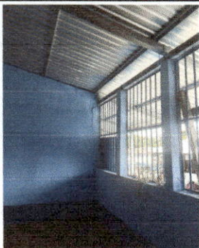
Foto 1: cambio de lamina de sinc por lamina troquelada
