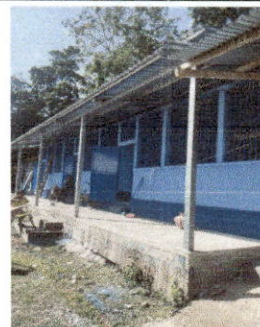
Foto: 6 mantenimiento a reposaderas de agua
