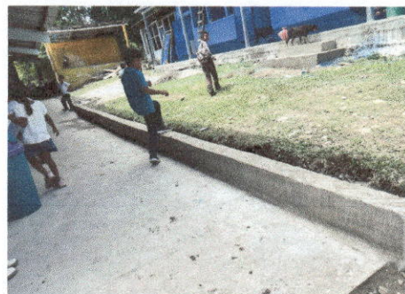
Foto 6 mantenimiento a reposaderas de agua
