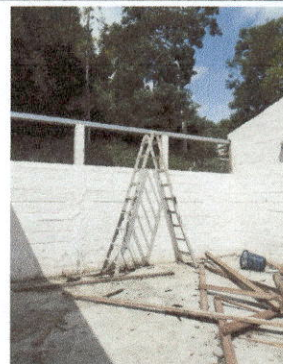
Foto 2 cambio de arteson por estructura metalica
