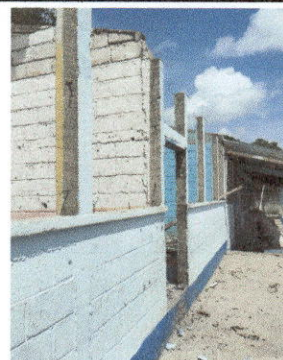
Foto 4 cambio de torta de cemento por piso pulido
