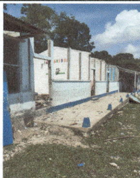
Foto 5 cambio de puertas de madera por metal
