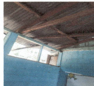
Foto: 2 cambio de arteson por estructura metalica
