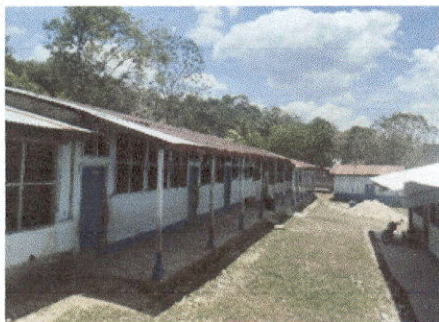
Foto: 5 cambio de puertas de madera por metal
