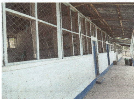
Foto: 3 cambio de ventanales por balcones de metal
