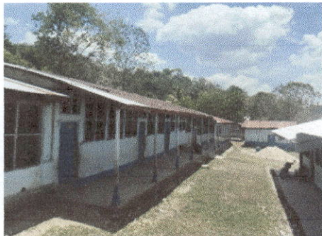
Foto 1: cambio de lamina de sinc por lamina troquelada
