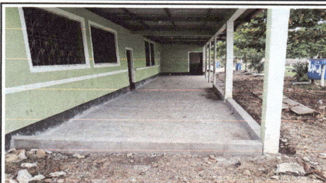
Foto 2: SUSTITUCION DE TORTA DE CONCRETO
