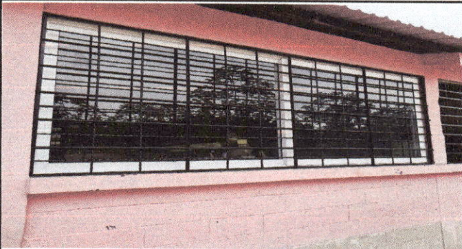
Foto 4: SUSTITUCION DE ESTRUCTURA DE METAL POR VENTANA PVC Y SUSTITUCION DE ESTRUCTURA DE METAL DE VENTANA POR BALCON
