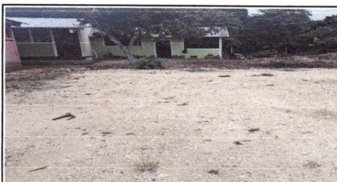
Foto 12: SUSTITUCION DE TUBERIA PVC LINEA PRINCIPAL AGUAS NEGRAS
