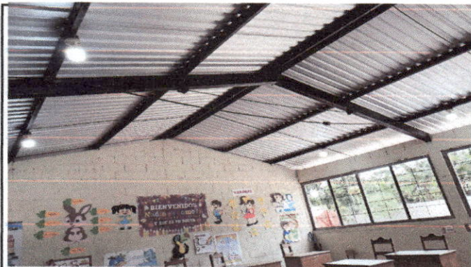
Foto 9: REPARACION DE CABLEADO ELECTRICO
