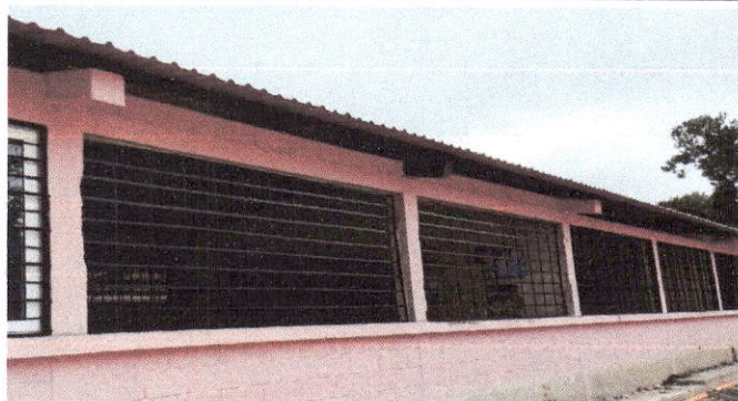
Foto: 3 MANTENIMIENTO A ESTRUCTURA DE METAL VENTANA
