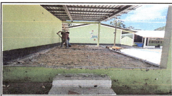
Foto 6: REPARACION DE PISO DE TORTA DE CONCRETO
