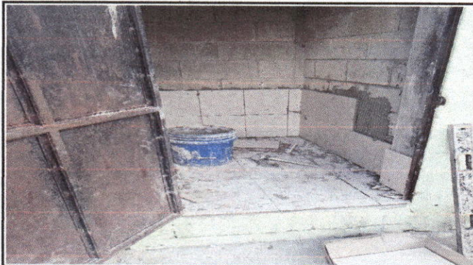
Foto 7: SUSTITUCION DE INODOROS
