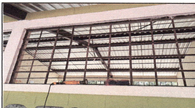
Foto: 3 MANTENIMIENTO A ESTRUCTURA DE METAL VENTANA
