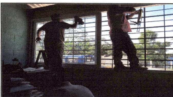
Foto 4: SUSTITUCION DE ESTRUCTURA DE METAL POR VENTANA PVC Y SUSTITUCION DE ESTRUCTURA DE METAL DE VENTANA POR BALCON
