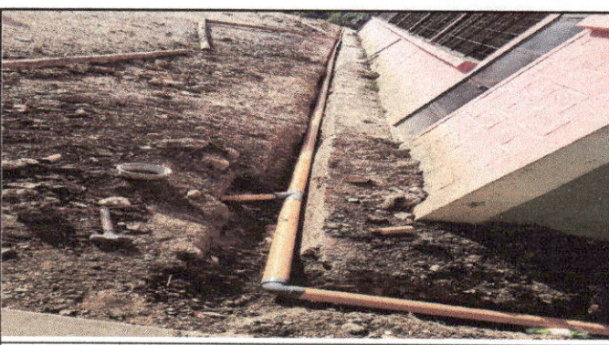
Foto 12: SUSTITUCION DE TUBERIA PVC LINEA PRINCIPAL AGUAS NEGRAS
