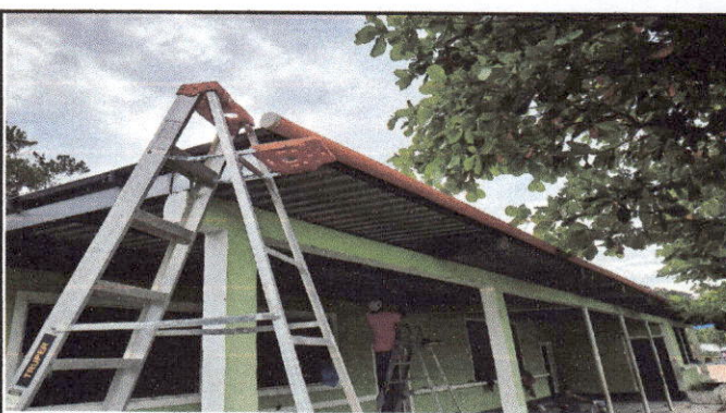
Foto 10: SUMINISTRO DE BAJADA DE AGUA PLUVIAL DE METAL POR TUBO PVC 3"
