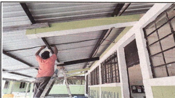
Foto 9: REPARACION DE CABLEADO ELECTRICO
