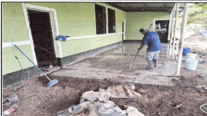
Foto 2: SUSTITUCION DE TORTA DE CONCRETO
