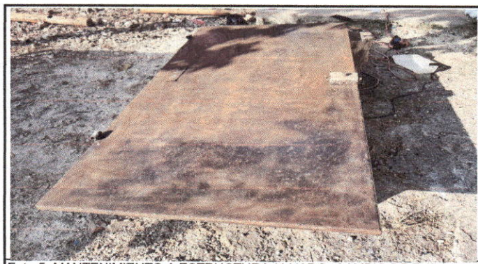
Foto 5: MANTENIMIENTO A ESTRUCTURA ( LIJADO, CAMBIO DE TUBO, CEPILLADO,SUJECIONES Y APLICACIÓN DE PINTURA)
