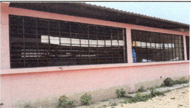
Foto: 3 MANTENIMIENTO A ESTRUCTURA DE METAL VENTANA
