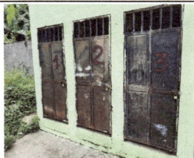
Foto 8: MANTENIMIENTO A ESTRUCTURA (LIJADO, CAMBIO DE TUBO, CEPILLADO, SUJECIONES, APLICACIÓN DE PINTURA) Y MEJORAMIENTO DE PISO POR PISO CERAMICO
