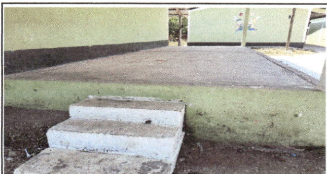
Foto 6: REPARACION DE PISO DE TORTA DE CONCRETO
