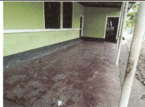
Foto 2: SUSTITUCION DE TORTA DE CONCRETO
