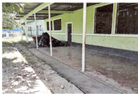
Foto 10: SUMINISTRO DE BAJADA DE AGUA PLUVIAL DE METAL POR TUBO PVC 3"
