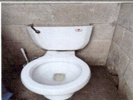
Foto 7: SUSTITUCION DE INODOROS
