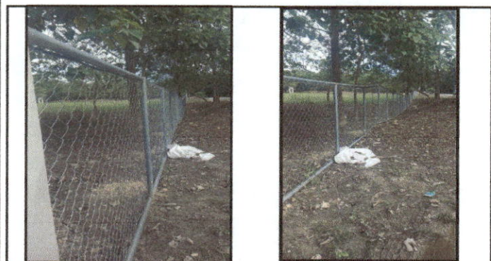
Foto 5: Reparación de tubo hg y malla galvanizada
