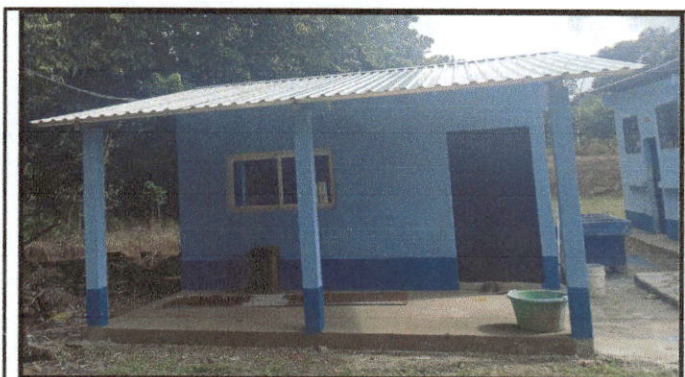
Foto 4: Sustrucción de piso de torta de concreto
