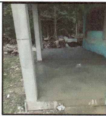
Foto 4: Sustitución de piso de torta de concreto
