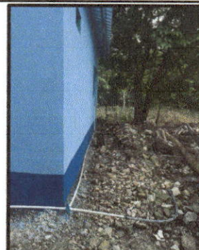
Foto 6: Instalación de tubería principal de PVC y Instalación de tubería para agua potables
