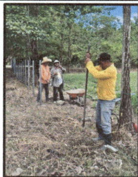
Foto 5: Reparación de tubo hg y malla galvanizada
