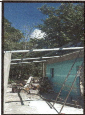
Foto 1: Sustitución de lámina, por lámina troquelada aluzinc calibre 26 y Sustitución de estructura de soporte de madera, por metal
