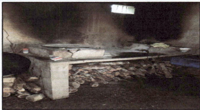
Foto 1:REGLÓN 20.2 Sustitución de estufa rural
