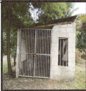
Foto 1: Sustitución de lámina, por lámina troquelada aluzinc calibre 26 y Sustitución de estructura de soporte de madera, por metal
