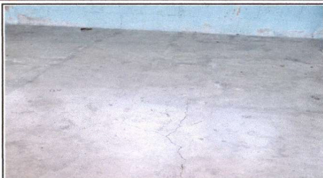
Foto 2: Sustrucción de Piso de Cemento Liquido
