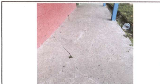
Foto 6: Sustrucción de Piso de Torta de Concreto
