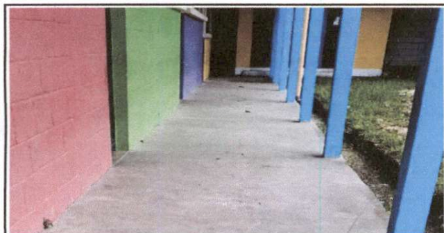
Foto 5: Sustrucción de Piso de Torta de Concreto
