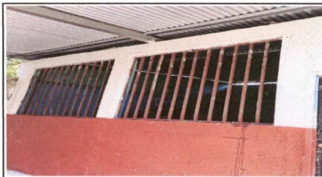
Foto 4: Sustrucción de Balcones de Metal
