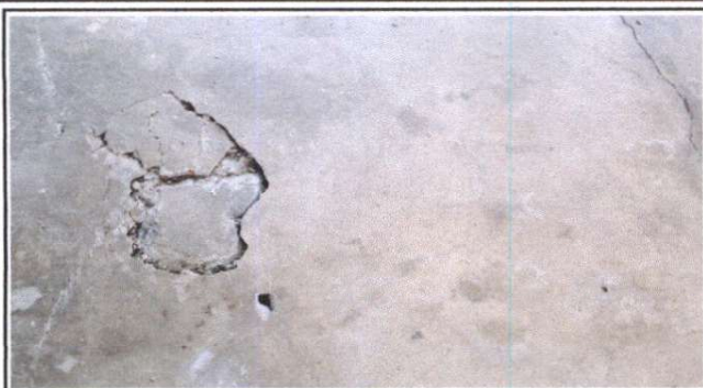
Foto 1: Sustrucción de Piso de Cemento Liquido
