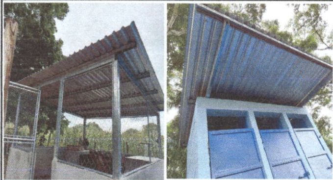
Foto 7: Sustitución de lámina, por lámina troquelada aluzinc calibre 26
