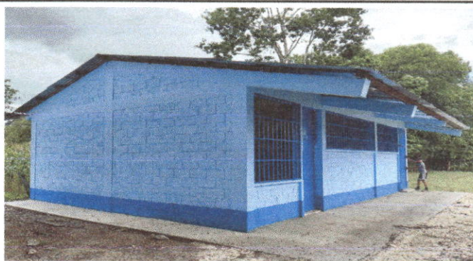
Foto 8: Pintura en muros exteriores e interiores
