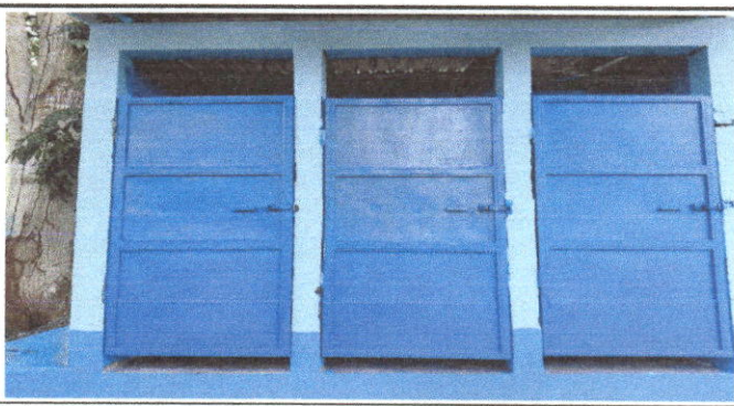
Foto 11. Mantenimiento a estructura (lijado, cambio de tubo , cepillado, sujeciones, aplicación de pintura) baños
