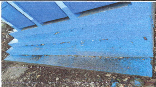
Foto 1: Reparación de gradas de baños
