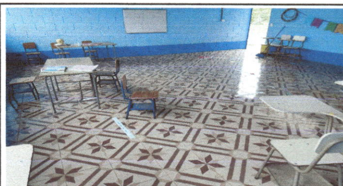
Foto 4: Sustitución de piso líquido por ceramico
