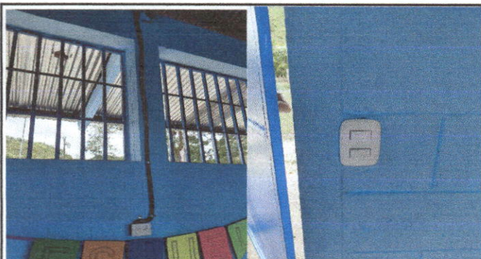
Foto 3: Reparación de cable electrico y accesorios
