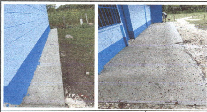
Foto 10. Reparación de banquetas de concreto
