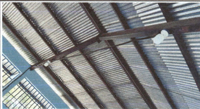
Foto 2: Reparación de cable electrico y accesorios
