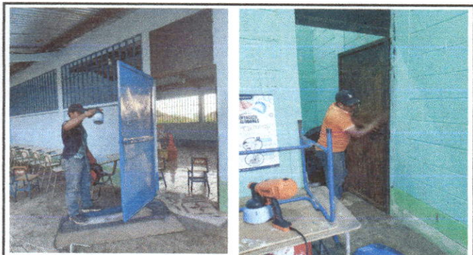
Foto 3: Mantenimiento a estructura (lijado, cepillado, aplicación de pintura) en aulas
