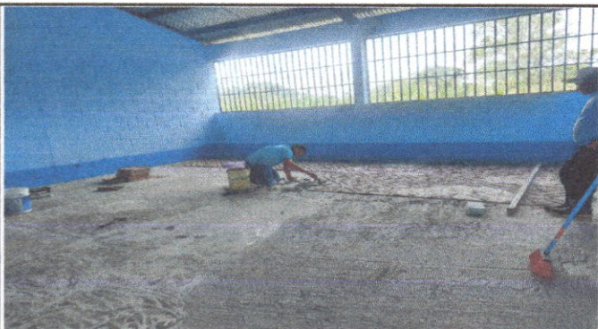
Foto 3 Sustitución de piso líquido por ceramico
