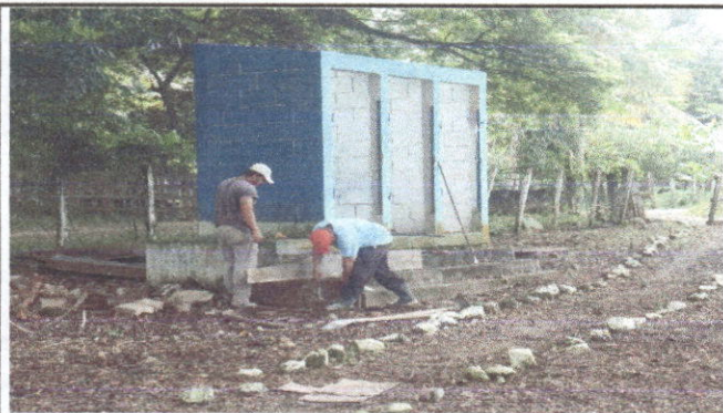
Foto 1: Reparación de gradas de baños
