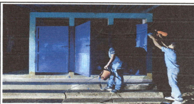
Foto 6. Mantenimiento a estructura (lijado, cambio de tubo, cepillado, sujeciones, aplicación de pintura) baños
