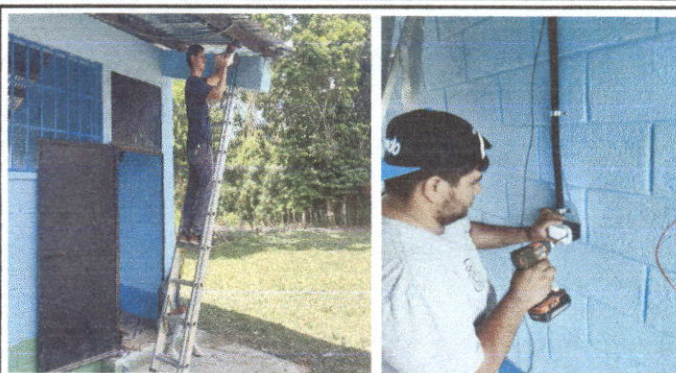
Foto 2: Reparación de cable eléctrico y accesorios
