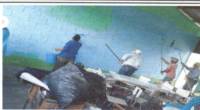
Foto 2: Pintura en muros exteriores e interiores
