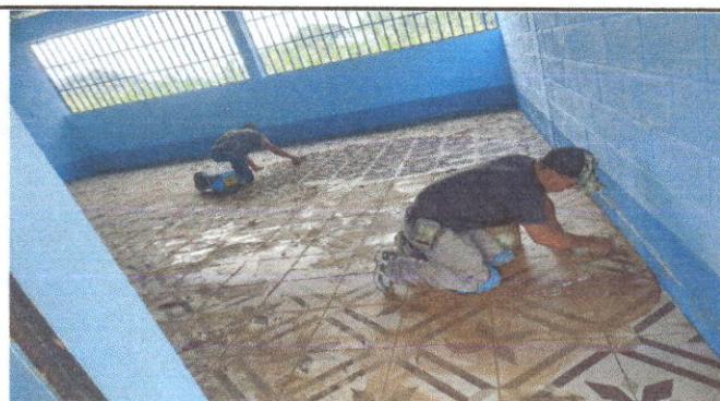
Foto 4 Sustitución de piso líquido por ceramico
