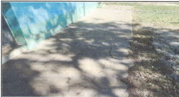
Foto 7 sustitucion de banquetas
