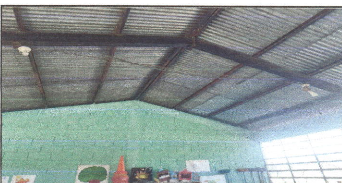
foto 6 Reparación de cable electrico
