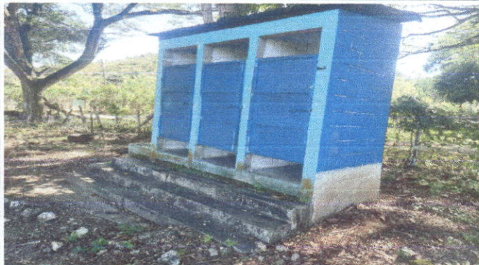
Foto 1 Reparacion y mantenimientode puertas
