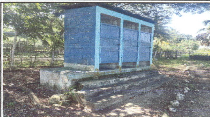
Foto 2 sustitucion de estructura de madera por metal
