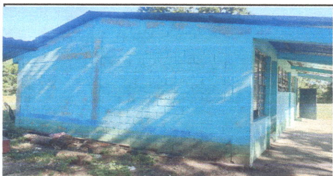
foto 5 Pintura en muros exteriores e interiores
