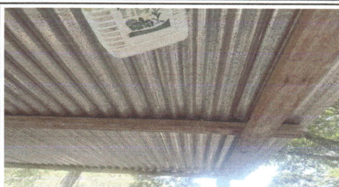
Foto 8: sustitucion de estructura de madera por metal
