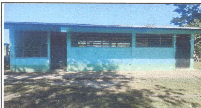
Foto 9 mantenimiento de puertas
