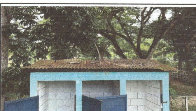
Foto Sustitución de estructura de madera por metal
