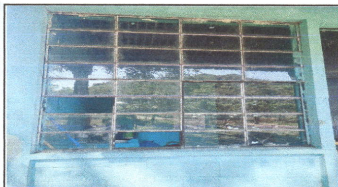
Foto 3 Sustitución de balcones
