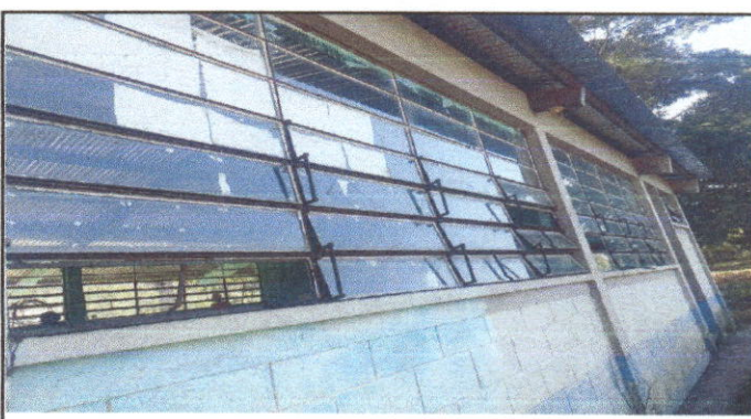
Foto 4 Sustitucion de balcones
