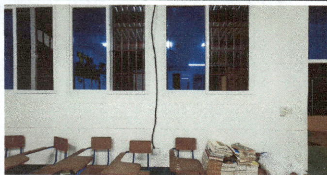
Foto1: sustitución de ducto eléctrico + accesorios
