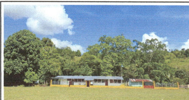
Foto 4: pintura en muro exterior e interior
