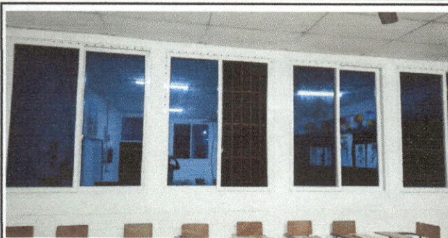
Foto 2: sustitución de ventanas pvc
