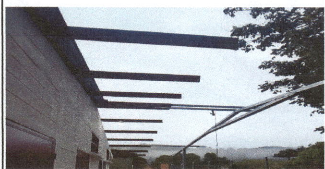
Foto 2: instalación de estructura de metal
