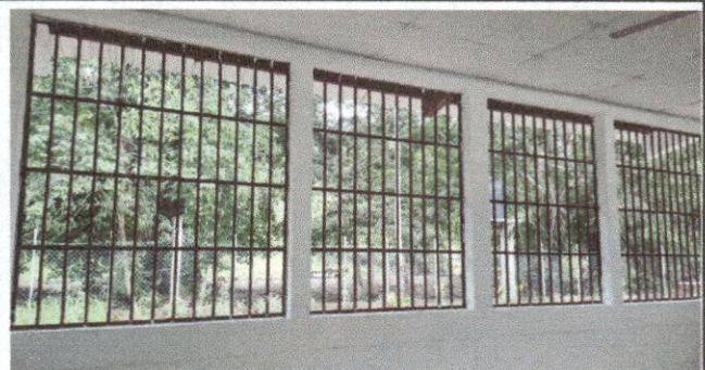
Foto 2: sustitución de ventana por ventana pvc
