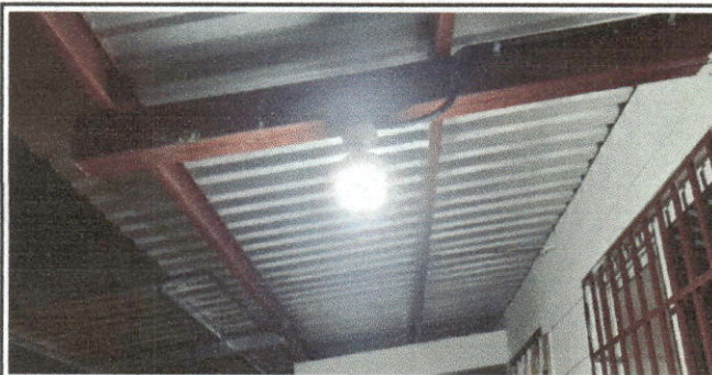
Foto 5: sustitución de focos ahorradores
