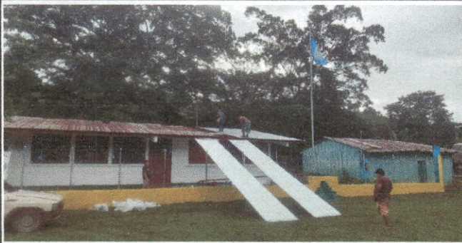
Foto1: sustitución de lámina, por láminas troquelada aluzinc calibre 26
