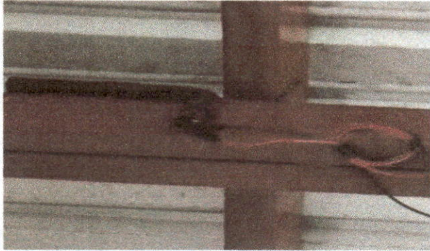
Foto 1: sustitución de ducto eléctrico + accesorios
