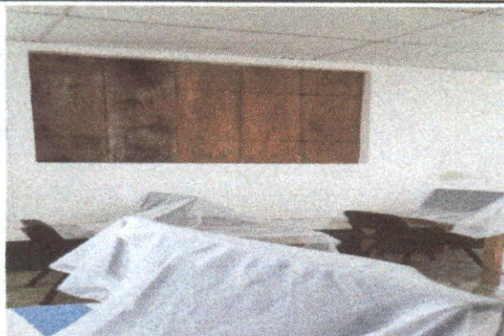
Foto 2 Sustrucción de de ventana de madera por metal mas vidrio
