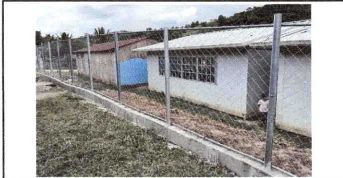
Foto 6: Reparación de tubo hg y malla galvanizada
