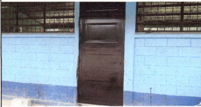
Foto 1: Sustrucción de puerta
