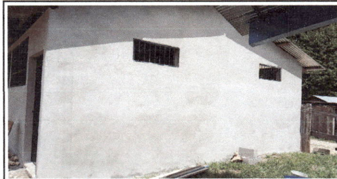
Foto 5: Repello en muro exterior y interior.
