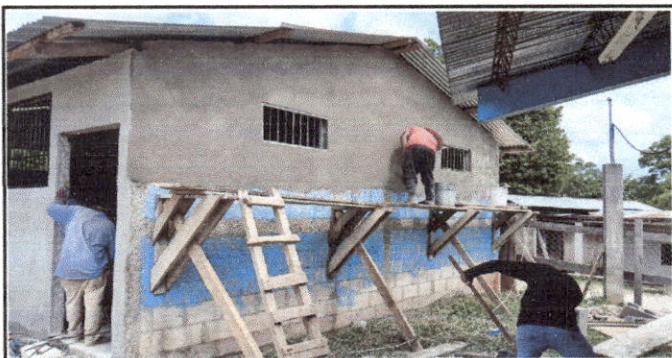
Foto 5: Repello en muro exterior y interior.
