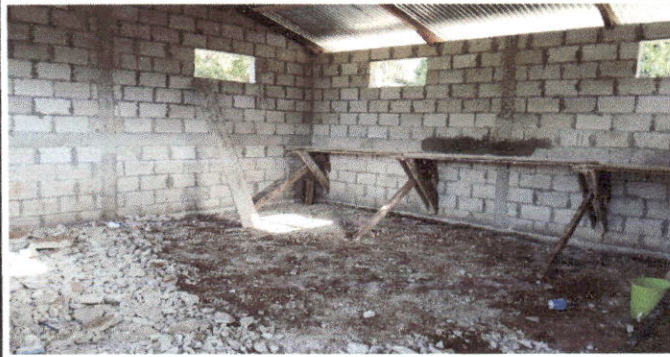
Foto 4: Sustitución de piso de torta de concreto
