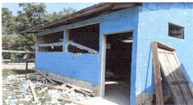
Foto 3 Sustitución de balcones de metal
