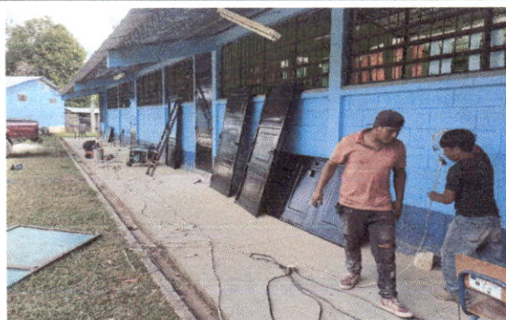
Foto 2: Sustitución de puerta
