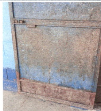
Foto 2: Sustrucción de puerta
