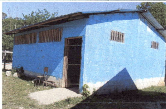
Foto 5: Repello en muro exterior y interior.
