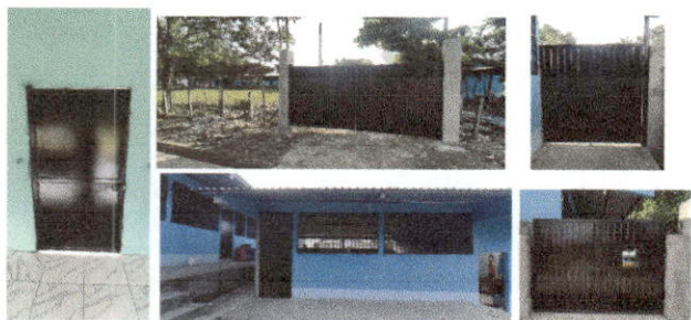
Foto 1: Sustitución de puertas y sustitución de portones de metal
