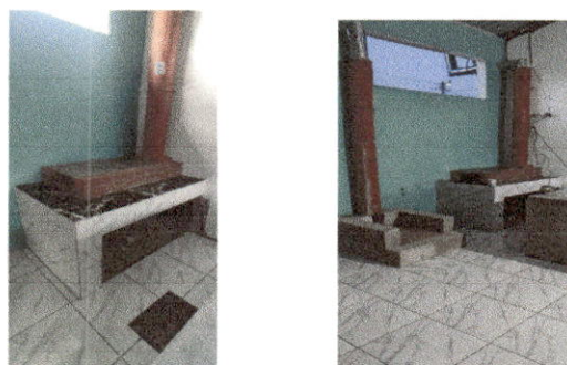
Foto: Sustitución de estufa rural (completa) incluye chimenea y plancha de metal
