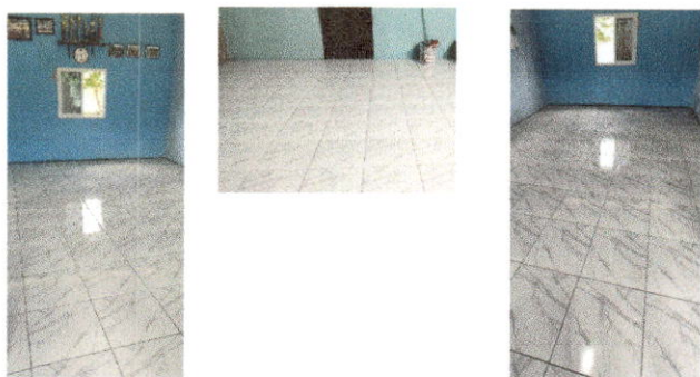
Foto: Sustitución de piso ceramico y sustutución de piso de torta de concreto
