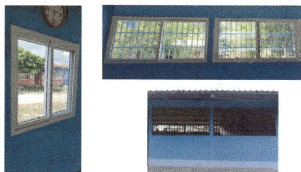
Foto: Sustitución de ventanas de madera por metal mas vidrio y sustitución de balcones de metal
