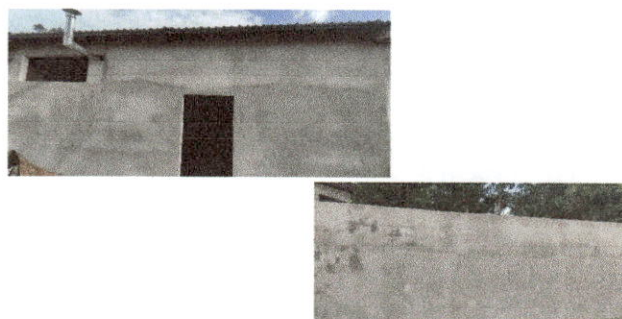
Foto: Repello en muro
