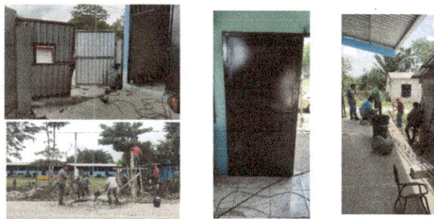
Foto 1: Sustitución de puertas y sustitución de portones de metal
