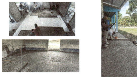
Foto: Sustitución de piso ceramico y sustutución de piso de torta de concreto
