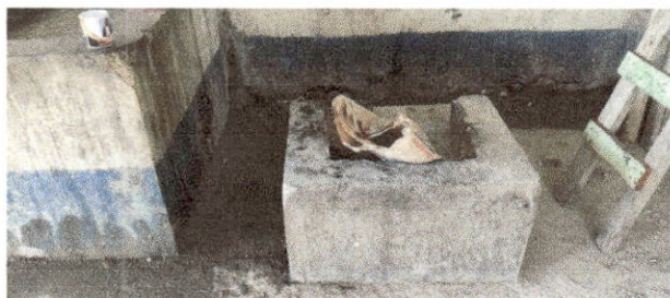
Foto: Sustitución de estufa rural (completa) incluye chimenea y plancha de metal
