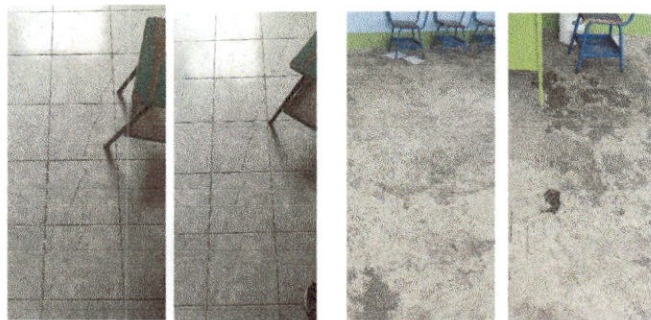
Foto: Sustitución de piso ceramico y sustutución de piso de torta de concreto
