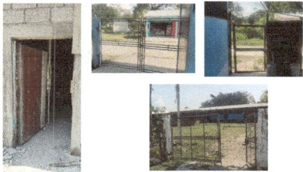
Foto 1: Sustitución de puertas y sustitución de portones de metal
