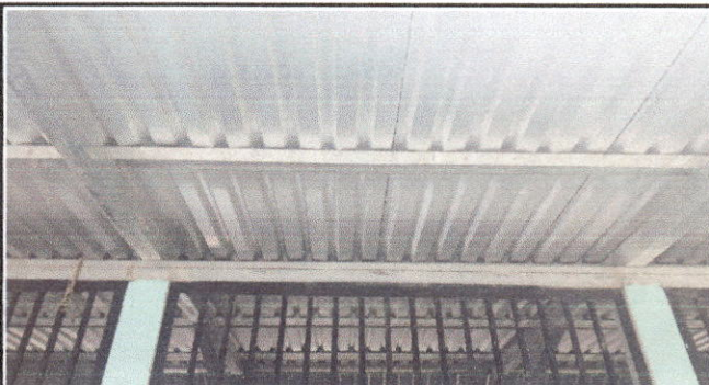
Foto 2: SUSTITUCION DE ESTRUCTURA PORTANTE DE METAL
