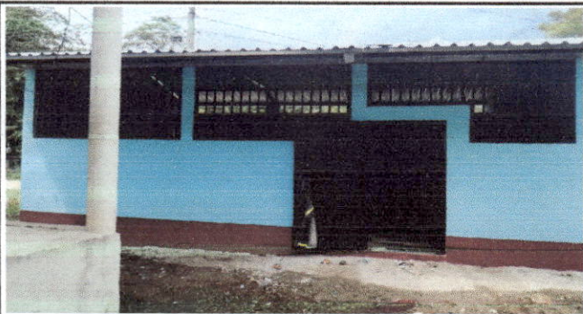
Foto1: SUSTITUCION DE PINTURA
