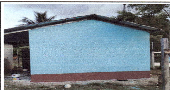
Foto 6: LEVANTAMIENTO DE MURO
