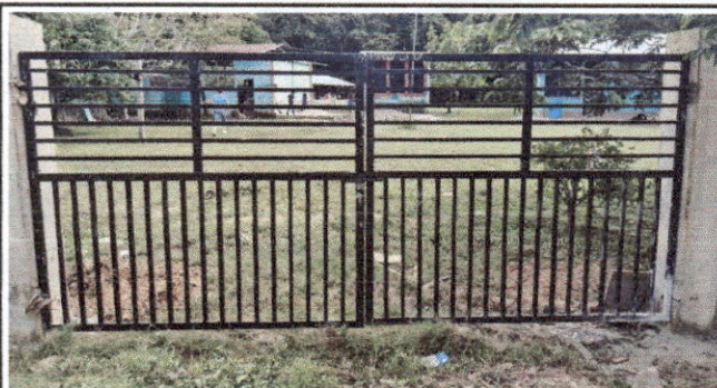
Foto 2: FABRICACION E INSTALACION DE PROTON DE METAL
