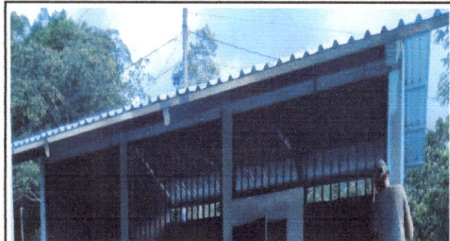
Foto1: SUSTITUCION DE TECHO Y ESTRUCTURA PORTANTE
