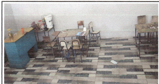
Foto 5: SUSTITUCION DE PISO LIQUIDO
