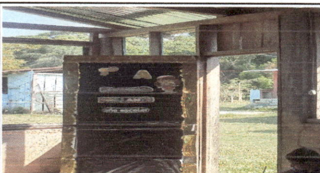
Foto 4: SUSTITUCION DE PUERTA DE METAL
