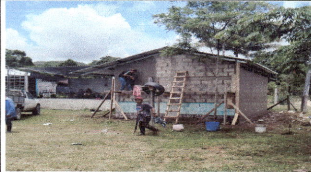
Foto 2: REPELLO EN MUROS
