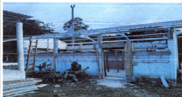
Foto 2: SUSTITUCION DE ESTRUCTURA PORTANTE DE METAL
