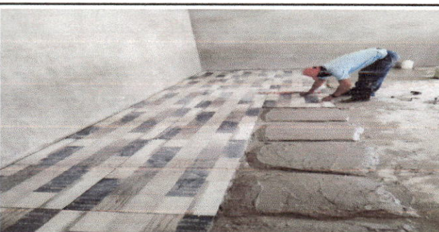
Foto 5: SUSTITUCION DE PISO LIQUIDO
