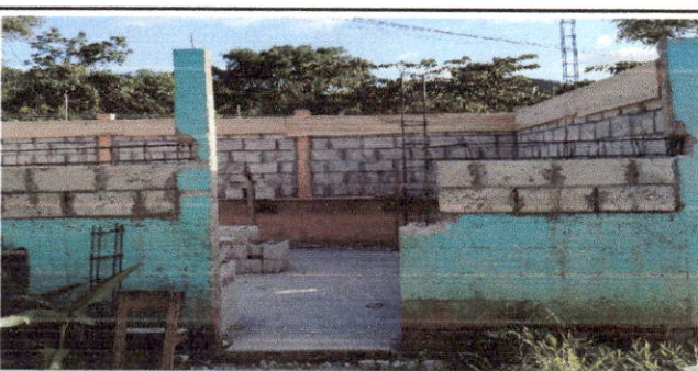
Foto 6: LEVANTAMIENTO DE MURO
