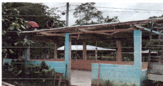
Foto 1: SUSTITUCION DE TECHO Y ESTRUCTURA PORTANTE
