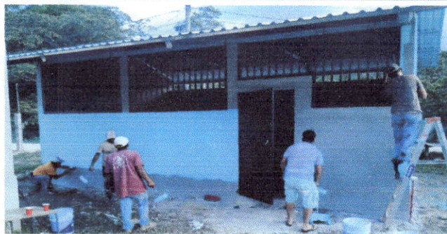
Foto1: SUSTITUCION DE PINTURA
