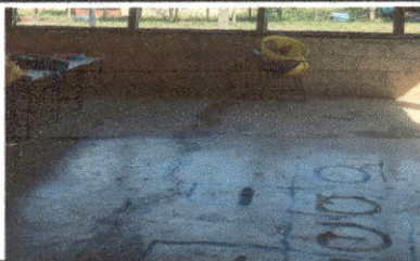
Foto 5: MEJORAMIENTO DE PISO
