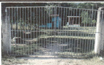
Foto7: SUSTITUCION DE PORTON DE METAL
