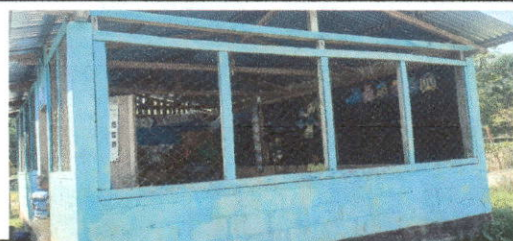
Foto 6: PINTURA EN MUROS INTERIORES Y EXTERIORES
