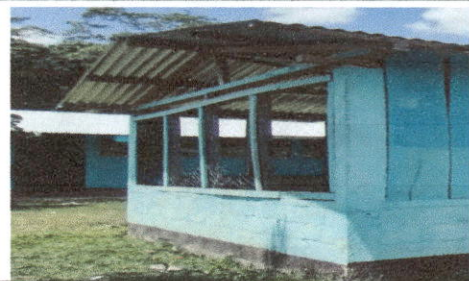
Foto 2: SUSTITUCION DE ESTRUCTURA PORTANTE DE METAL
