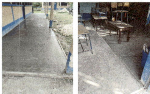
Foto1: 6.5 SUSTITUCIÓN DE PISO DE TORTA DE CONCRETO
