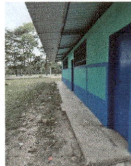
Foto 2: 9.2 PINTURA EN MUROS EXTERIORES E INTERIORES
