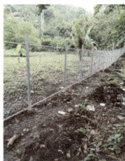
Foto 3: 15.3 REPARACIÓN DE TUBO HG Y MALLA GALVANIZADA
