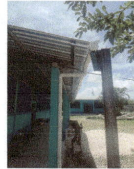
Foto 8. SUMINISTRO E INSTALACIÓN BAJADAS DE AGUA FLUVIAL
