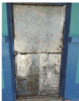
Foto 9: 4.1 MATENIMIENTO A ESTRUCTURA(LIJADO, CAMBIO DE TUBO, CEPILLADO, SUJECIONES, APLICACIÓN DE PINTURA)
