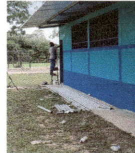
Foto 2: 9.2 PINTURA EN MUROS EXTERIORES E INTERIORES
