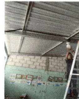
Foto 6: SUSTITUCIÓN DE FOCOS AHORRADORES
