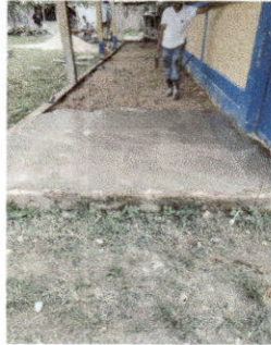
Foto 1: 6.5 SUSTITUCIÓN DE PISO DE TORTA DE CONCRETO
