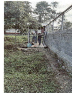
FOTO 4: 19.5 FABRICACION E INSTALACIÓN DE PORTON DE METAL DE INGRESO
