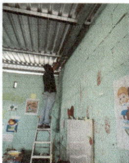
Foto7: 17.11 REPARACIÓN DE CABLEADO ELÉCTRICO
