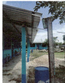
Foto 8. SUMINISTRO E INSTALACIÓN BAJADAS DE AGUA FLUVIAL
