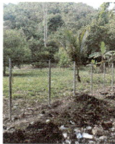
Foto 3: 15.3 REPARACIÓN DE TUBO HG Y MALLA GALVANIZADA
