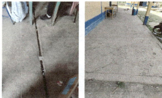
Foto1: 6.5 SUSTITUCIÓN DE PISO DE TORTA DE CONCRETO
