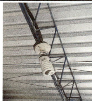
Foto 6: SUSTITUCIÓN DE FOCOS AHORRADORES
