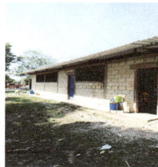
Foto 2: 9.2 PINTURA EN MUROS EXTERIORES E INTERIORES
