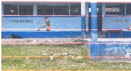
Foto 7: Pintura en muros exteriores
