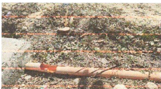
Foto 9: Sustitución de tubería PVC línea principal aguas negras (3 pulg o 4 pulg)
