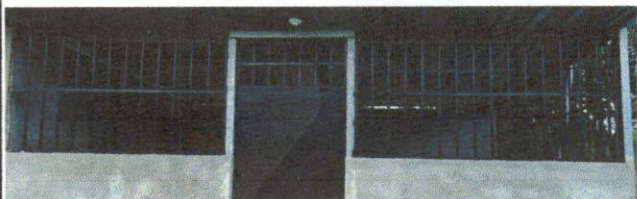
Foto 3: Sustitución de balcones de metal
