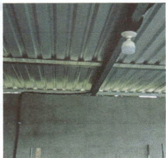
Foto 5: Reparacion de sistema electrico
