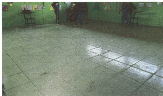
Foto 4: Sustitución de piso de torta de concreto
