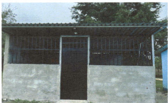
Foto 1: Sustitución de lámina, por lámina troquelada aluzinc calibre 26, Sustitución de estructura de soporte de madera, por metal
