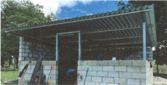
Foto 1: Sustrucción de lámina, por lámina troquelada aluzinc calibre 26, Sustrucción de estructura de soporte de madera, por metal
