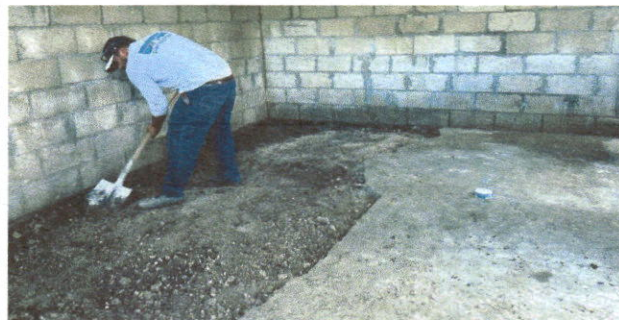
Foto 4: Sustrucción de piso de torta de concreto
