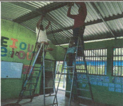
Foto 5: Reparacion de sistema electrico
