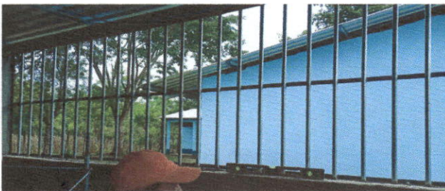
Foto 3: Sustrucción de balcones de metal
