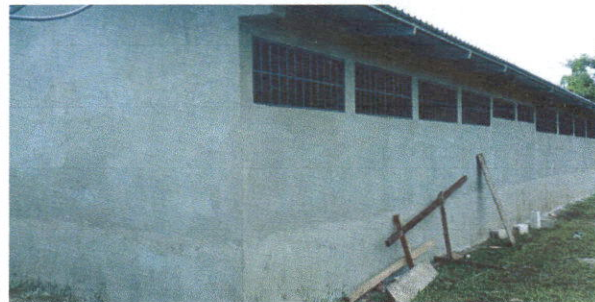
Foto 6: cernido en muros
