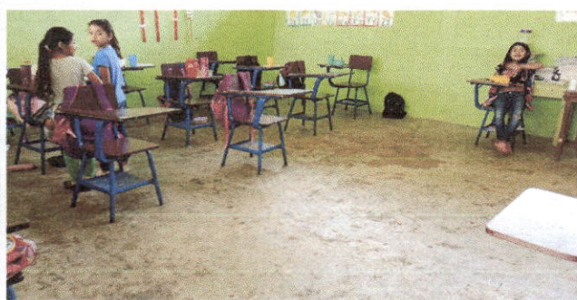
Foto 3: Sustitución de piso de torta de concreto
